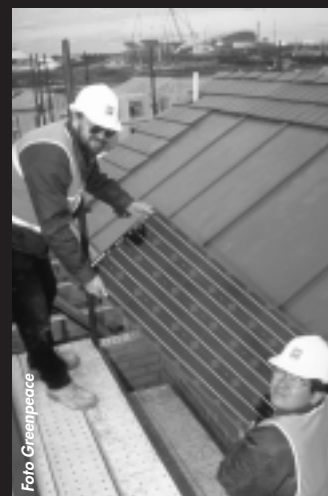
Pokládání solárních fotovoltaických článků v olympijské vesničce v Sydney.
